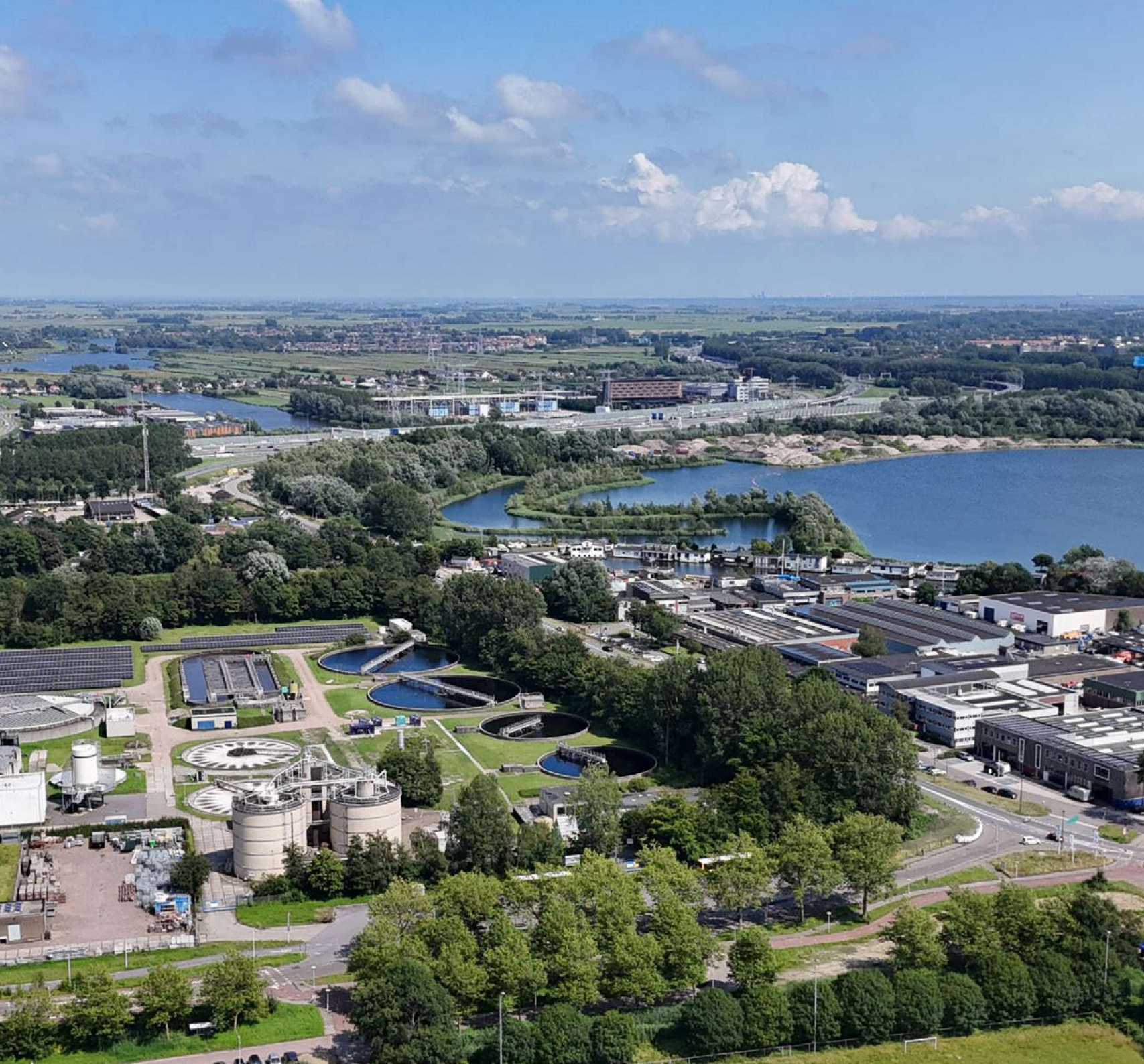
Figuur 12 De RWZI met rechts het Barndegat (het toekomstige Sluiskwartier) en de Noorder IJ-plas
